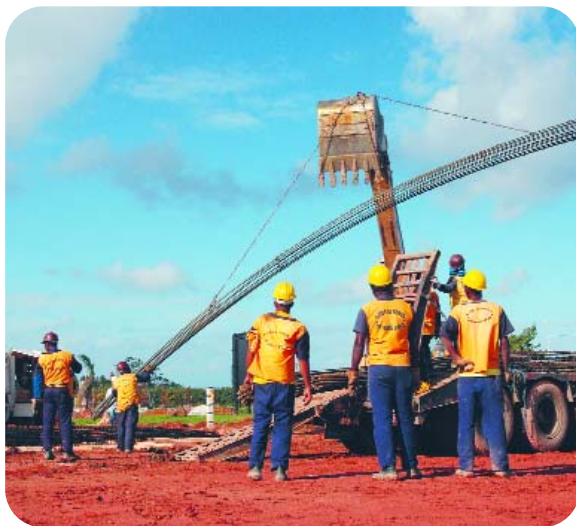
Obra de infra-estrutura
