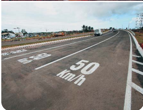
Complexo Viário Dois de Julho
