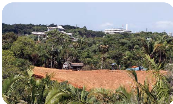
Obra do Parque Tecnológico da Bahia
