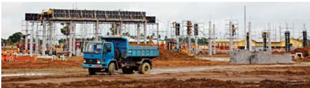
Fábrica de alimentos e bebidas em construção - Feira de Santana
