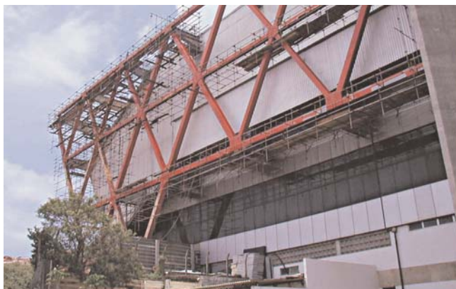
Obras no Centro de Convenções
