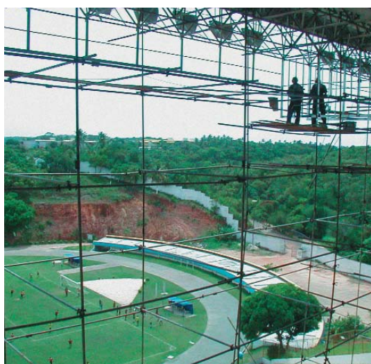
Obras no Estádio de Pituacu
