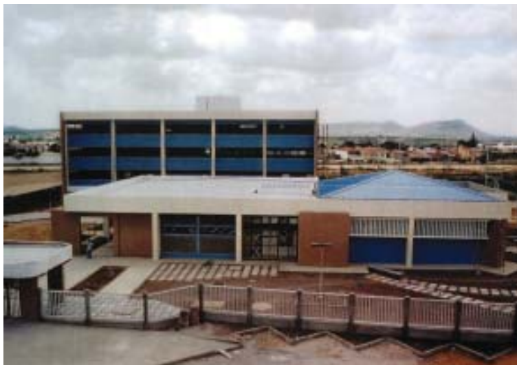
O Colégio Modelo Luís Eduardo Magalhães, em Senhor do Bonfim, que encontra-se em fase final de construção
