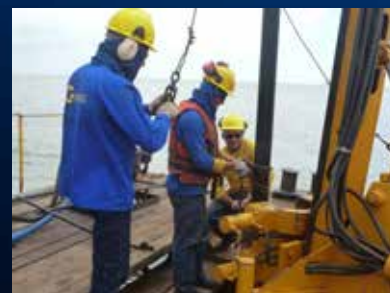
Equipe de sondagem trabalhando na cravação dos revestimentos
