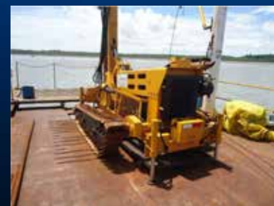
Equipamento: perfuratriz hidráulica que auxilia na cravação dos revestimentos
